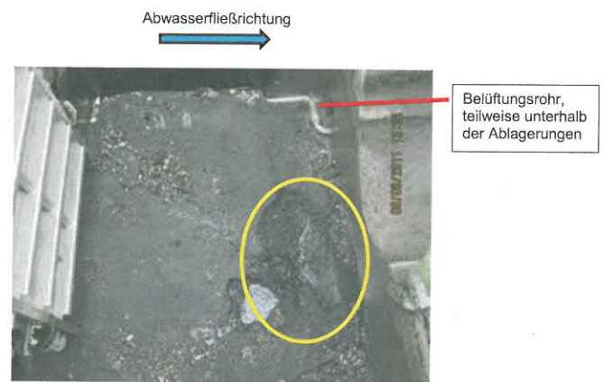
Abb. 6: In einem Geschiebeschacht zurückgehaltene, mineralische Grobstoffe nach einem Regenereignis (Foto: S. Hazra)
